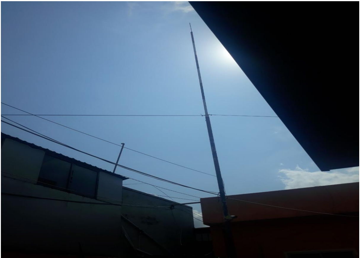
Hình 3.7. Thiết bị chống sét của cửa hàng
